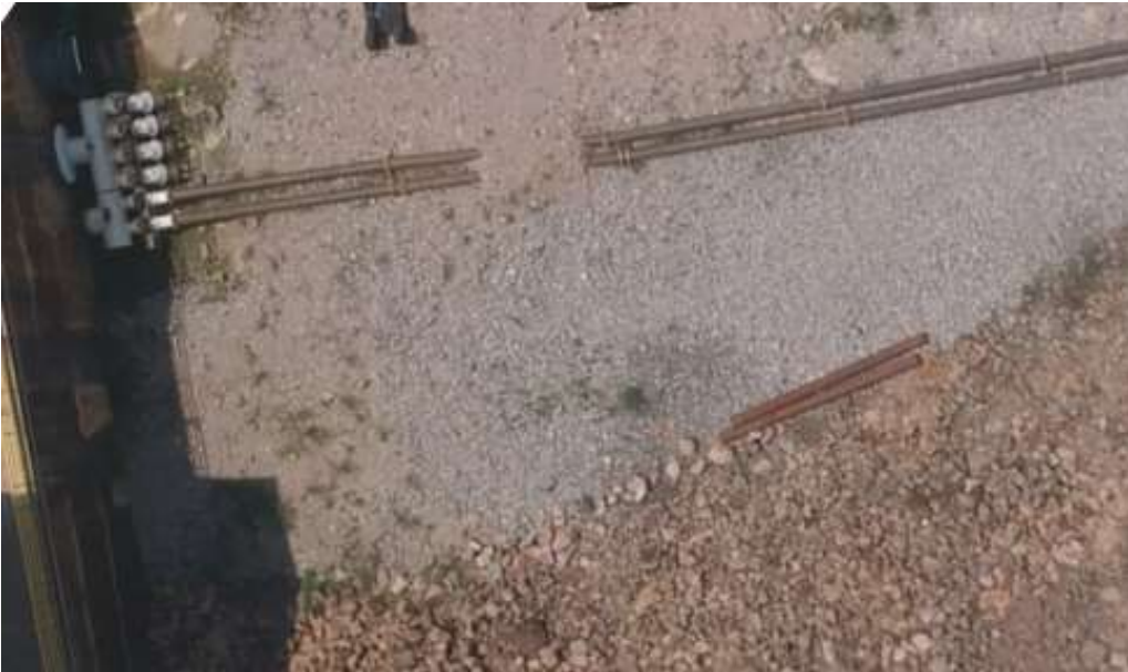
Figura 68 - Detalhe 2 da captação da UHE de Santo Antônio
