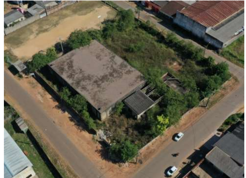
Figura 187 - Centro de distribuição do Setor Sul, 2022
