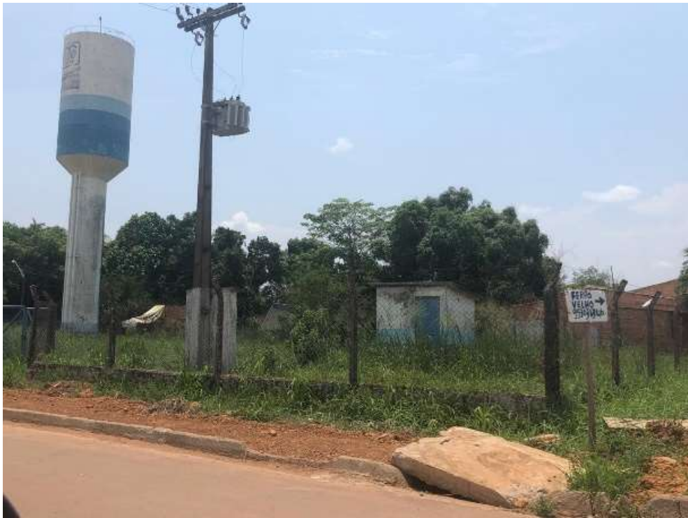
Figura 106 - Centro de Distribuição do Sistema Conjunto Ronaldo Aragão
