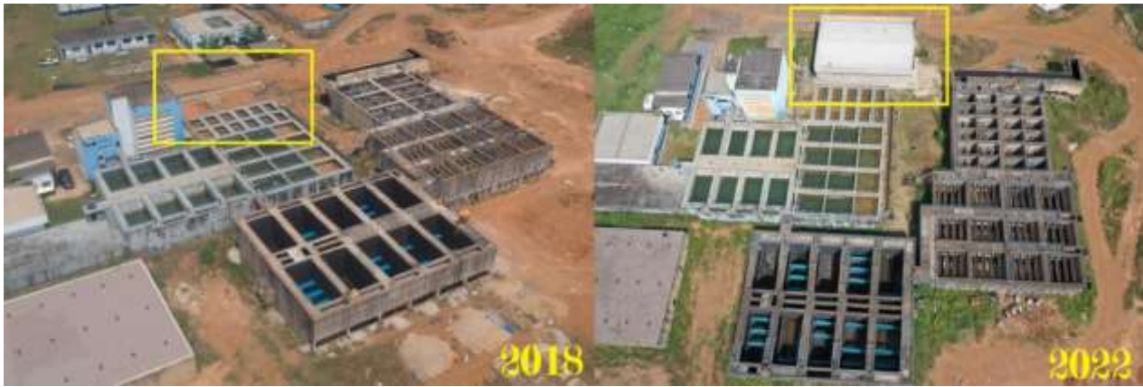
Vista geral da ETA 01 existente vazão de 600 l/s construído no final da década de 1970 e ETA 02 em construção vazão de 1.000 l/s. A esquerda, imagem do ano de 2018 com parte do depósito químico em execução. A direita, imagem do ano de 2022 com a estrutura do depósito concluída. Notável a pouca evolução da ETA 02 em execução.
