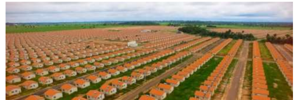
Figura 130 - Vista do empreendimento MCMV no sistema Cristal da Calama
