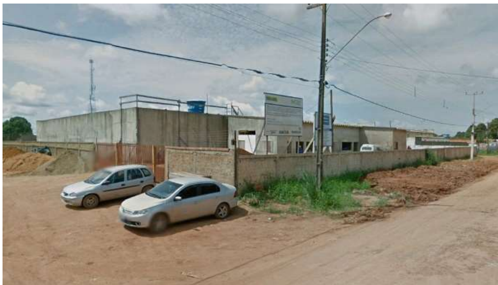
Figura 186 - Centro de distribuição do Setor Sul, 2018.
