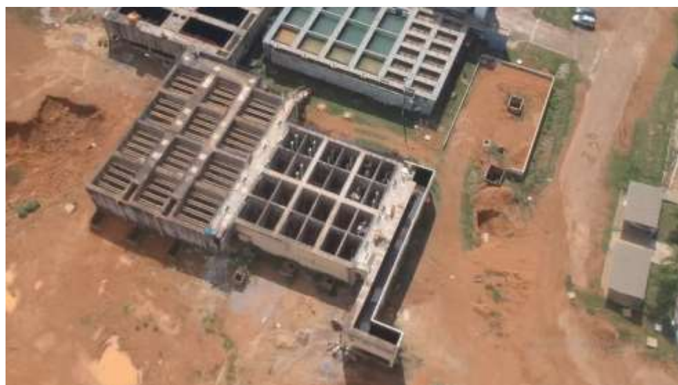
Figura 182 - Visão geral da caixa de chega e mistura rápida
