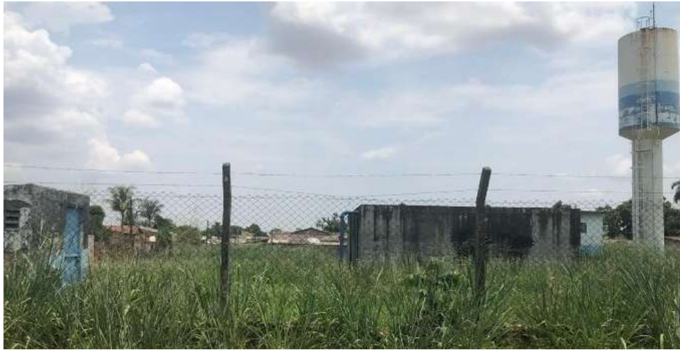
Figura 100 - Centro de Distribuição do Sistema Tancredo
