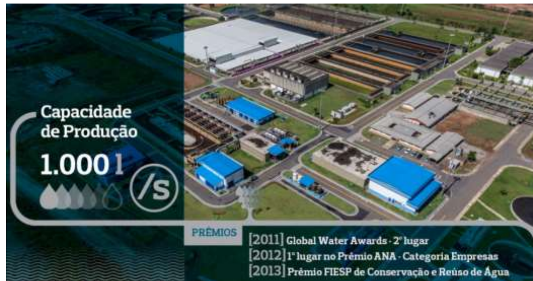
Figura 1 - Foto Aérea do Aquapolo, Maior Estação de Reuso do Hemisfério Sul.
