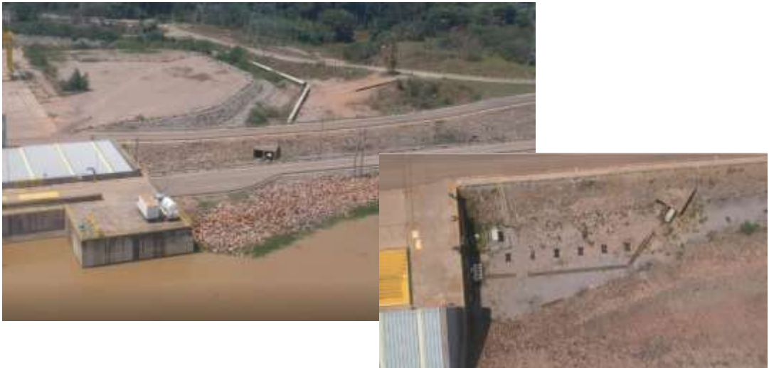
Figura 65 - Visão geral da captação na represa da UHE de Santo Antônio, 2018.
