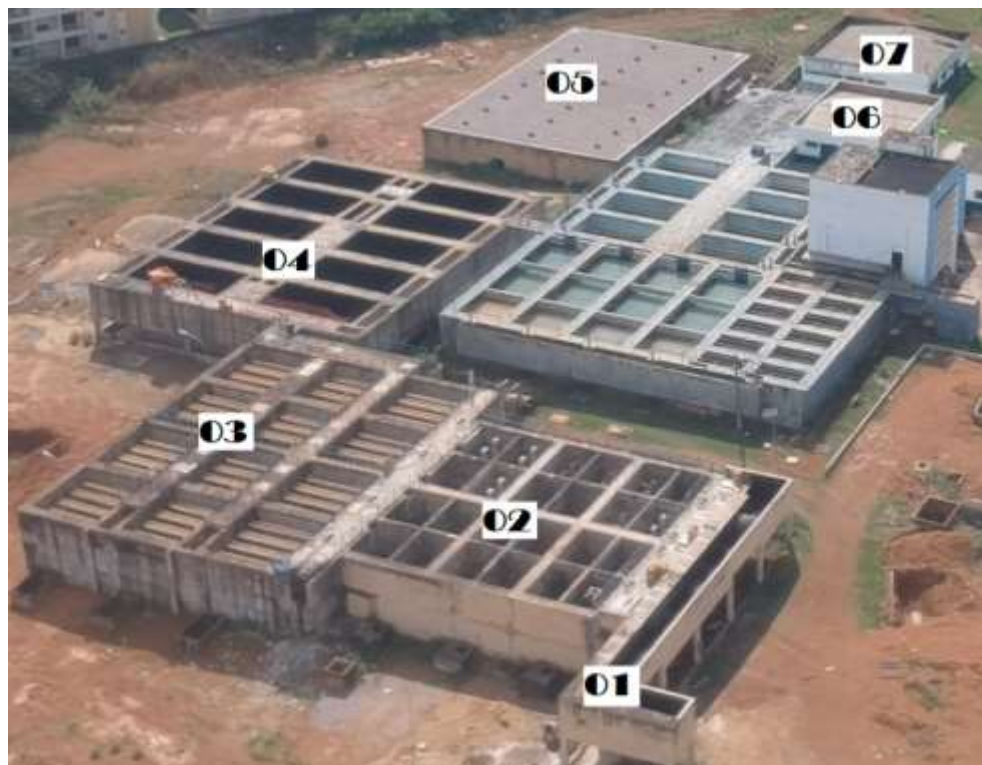
Figura 78 - Visão Geral da ETA 02 (em construção), 2018.
