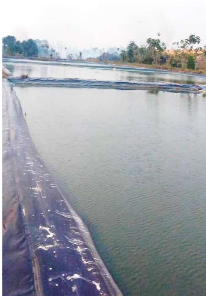
Figura 174 - Lagoa de Tratamento da Vila de Nova Mutum
