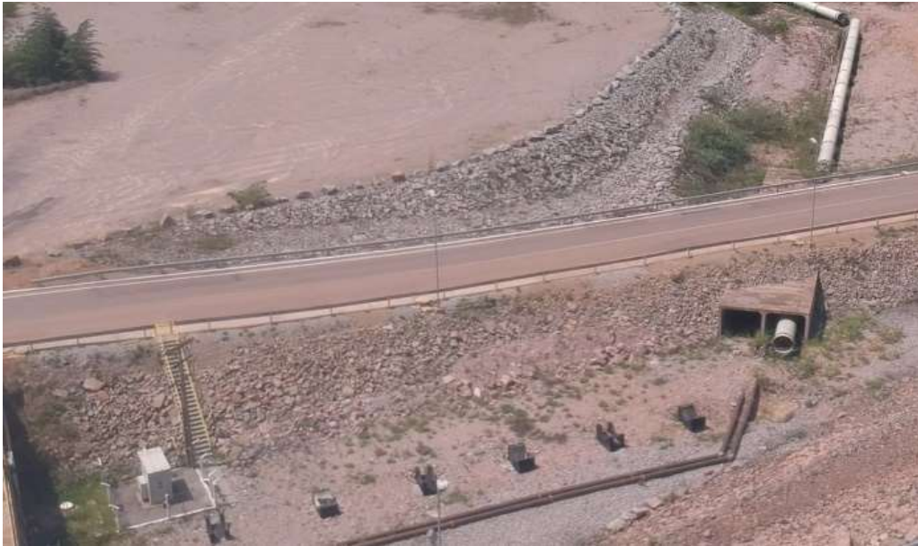
Figura 67 – Detalhe 1 da Captação da UHE de Santo Antônio, 2018.
