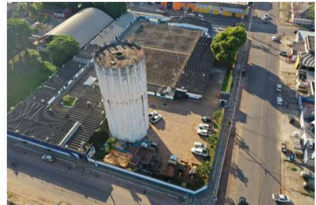
Figura 184 - Centro de distribuição do Setor R1, 2022..
