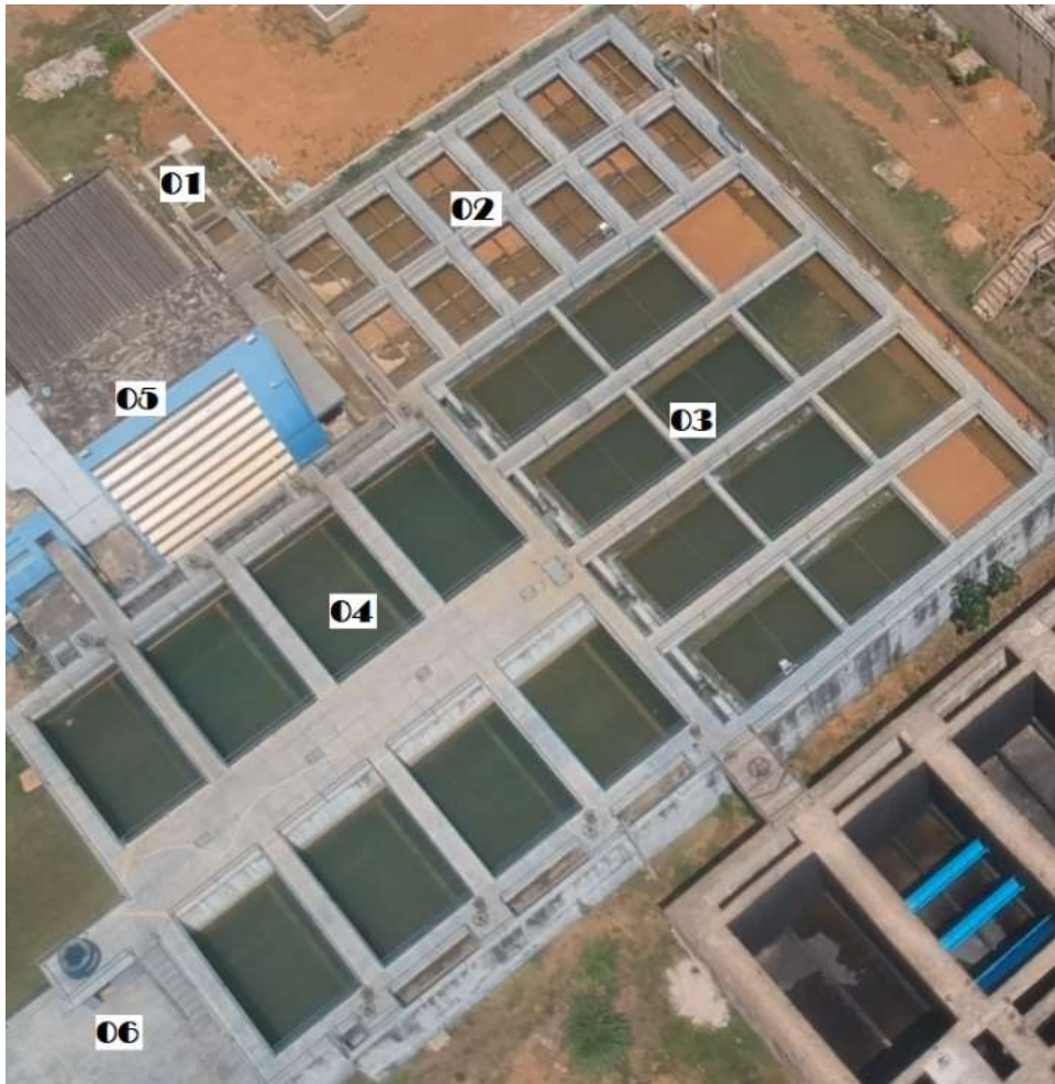
Figura 178 - Visão Geral da ETA 01
