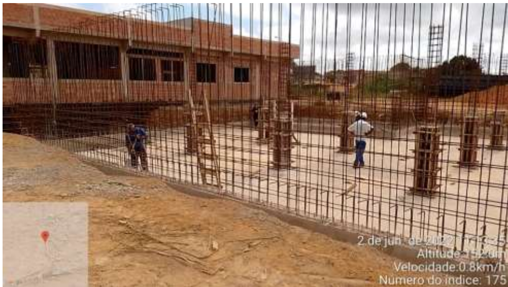
Figura 125 - Concretagem do reservatório apoiados de 1.000 m³ e ao fundo edificação em construção da casa de bombas, sala de dosagem/depósito de produtos químicos e escritório de administração do SAA do distrito de União Bandeirantes, Junho/2022
