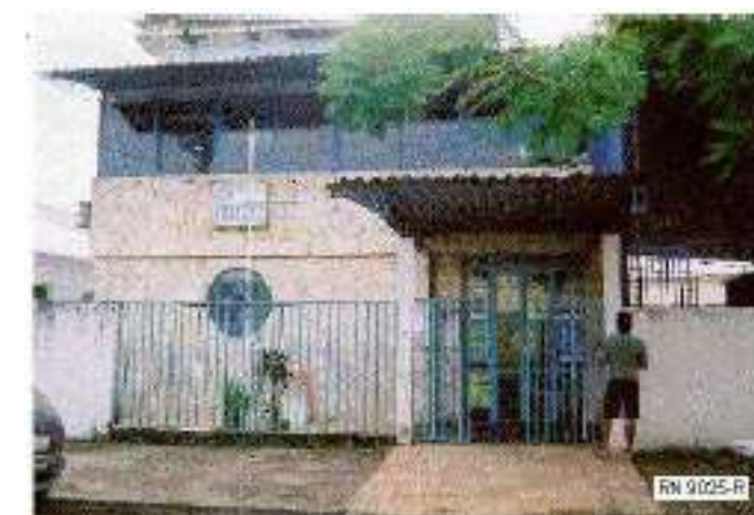
Figura 34 - Estação 9025R (Prisma quadrangular de concreto, medindo 30cm de lado e altura de 50cm, com chapa de metal cravado no topo, estampada).
