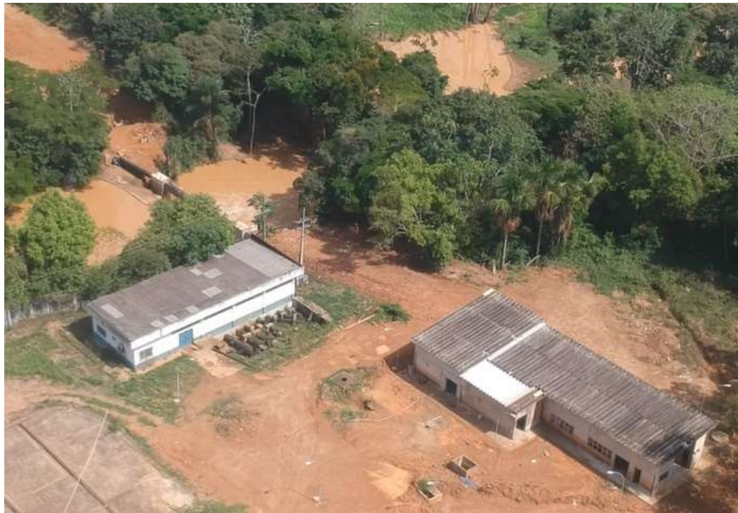
Figura 74 - Visão Geral da Captação e EEAB Bate-Estacas
