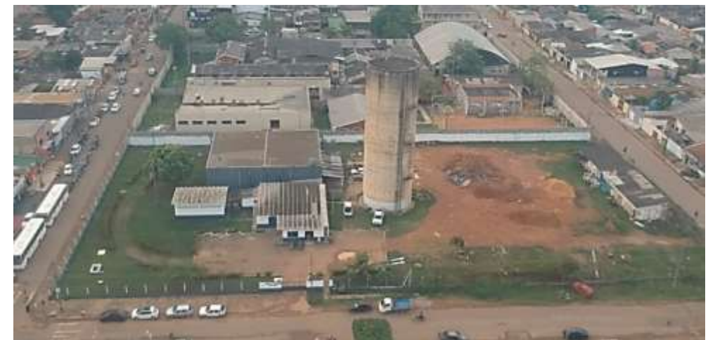
Figura 95 - Visão Geral do Centro de Distribuição do Sistema Tancredo, 2018.
