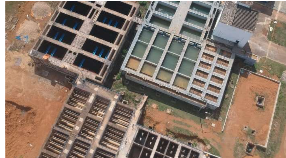
Figura 183 - Visão geral dos módulos de floculação
