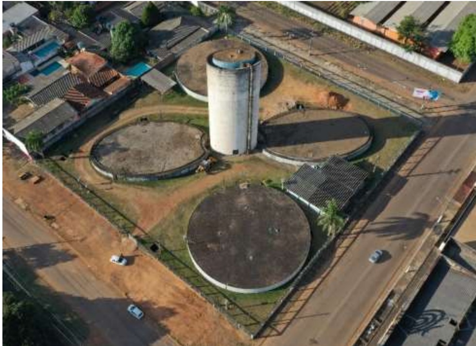
Figura 185 - Centro de distribuição do Setor R2, 2022.
