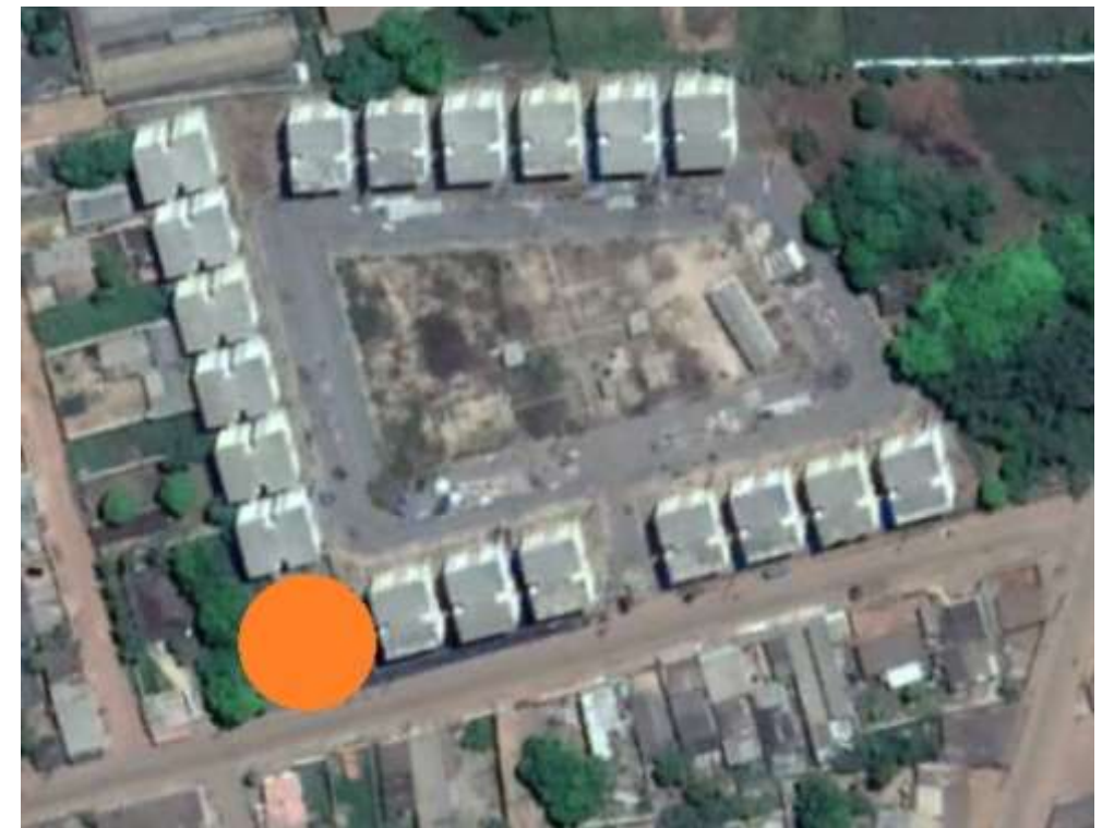
Figura 141 - Localização da ETE Porto Fino
