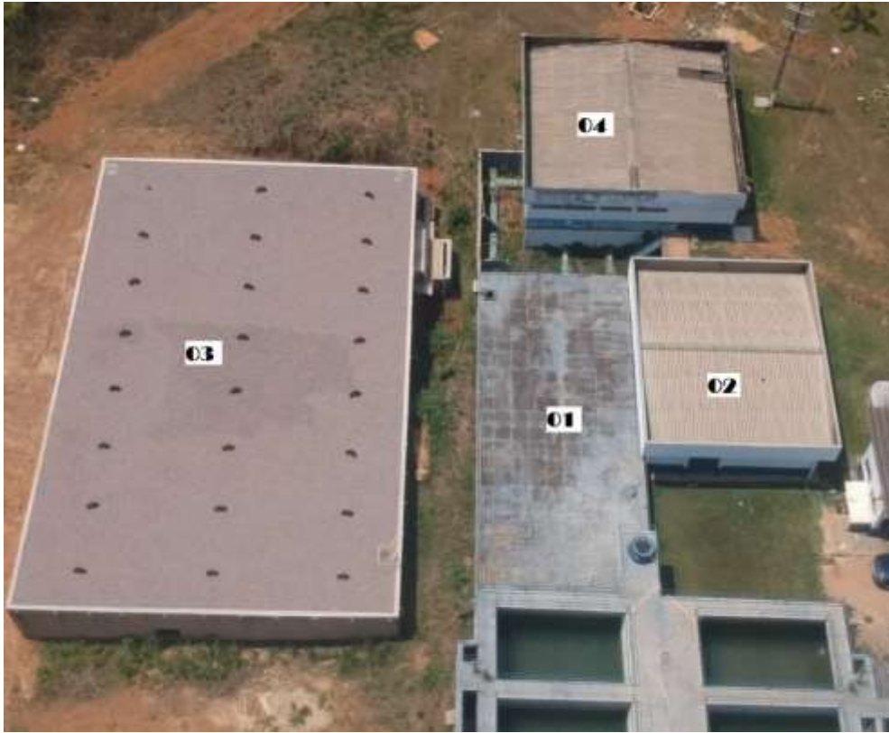
Figura 82- Visão geral da EEAT 01, EEAT 02 e reservatórios, 2018.
