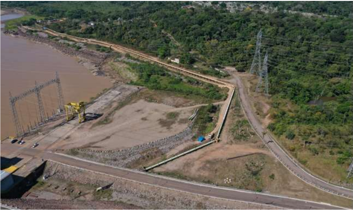
Figura 70 -Vista do caminhamento da adutora de DN 1.400 mm, na margem direita do Rio Madeira. Trecho inicial ainda sem tubulação.do Rio Madeira. Trecho inicial ainda sem tubulação, junho/2022
